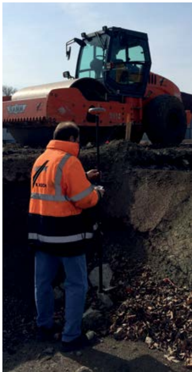
Volumenberechnung einer Baugrube
