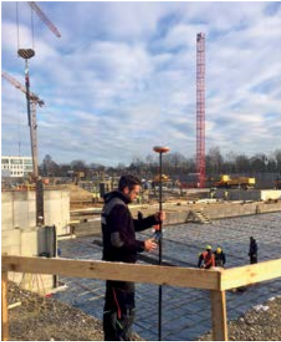
Abstecken von Punkten und Achsen im Tiefbau
