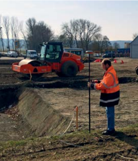
Abstecken von Punkten und Achsen im Tiefbau
