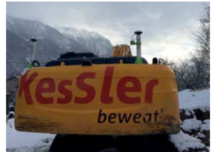
Einrichten eines Baggers mit GNSS-Empfängern
