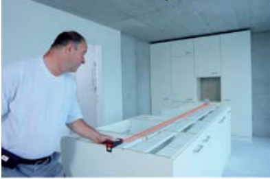
Vermessung im Innenbereich
