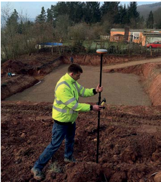
Volumenaufnahme eines Hügels und des dazugehörigen Aushubs durch ein Ingenieur- und Vermessungsbüro
