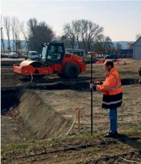
Abstecken von Punkten und Achsen im Tiefbau
