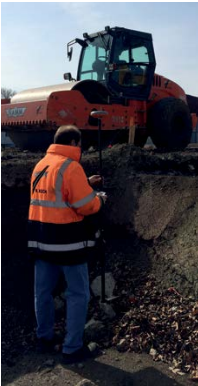
Volumenberechnung einer Baugrube
