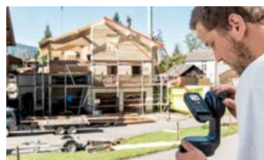
X4 - Messung der Dachschräge mit Hilfe des DST360 Adapters
