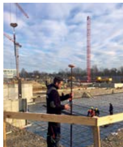
Abstecken von Punkten und Achsen im Tiefbau
