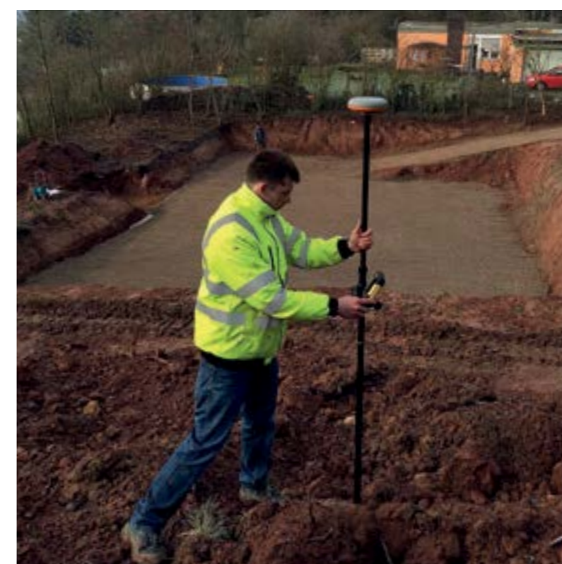
Volumenaufnahme eines Hügels und des dazugehörigen Aushubs durch ein Ingenieur- und Vermessungsbüro
