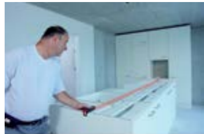
Vermessung im Innenbereich
